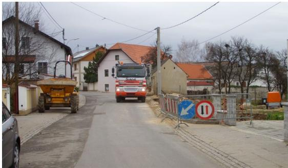
Im Zuge der Kanalauswechslung im Bereich „Am Platzl“ wurde die Abfahrt zum Objekt der Familie Halm umgestaltet. Die Fahrbahn des Güterwegs wurde verlegt, damit Beschädigungen des Objekts durch landwirtschaftliche Fahrzeuge ausgeschlossen werden können.
