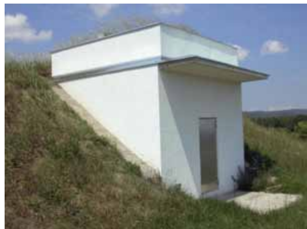
Hochbehälter nach Sanierung
