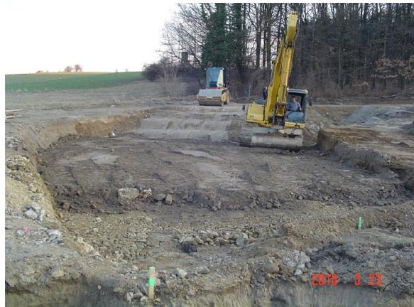
RHB Mühlgraben 2 – Dammaufbau in einzelnen Schichten
