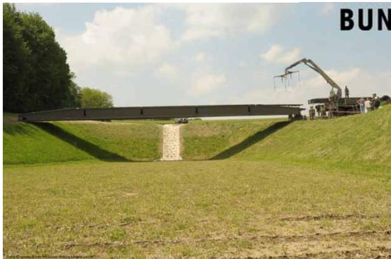
Fertig aufgebaute Pionierbrücke 2000 ...
