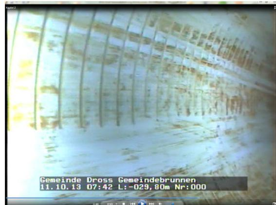
Filterrohr nach der Reinigung und Regenerierung
