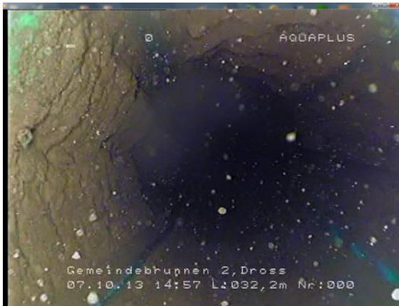
Filterrohr vor der Reinigung und Regenerierung
